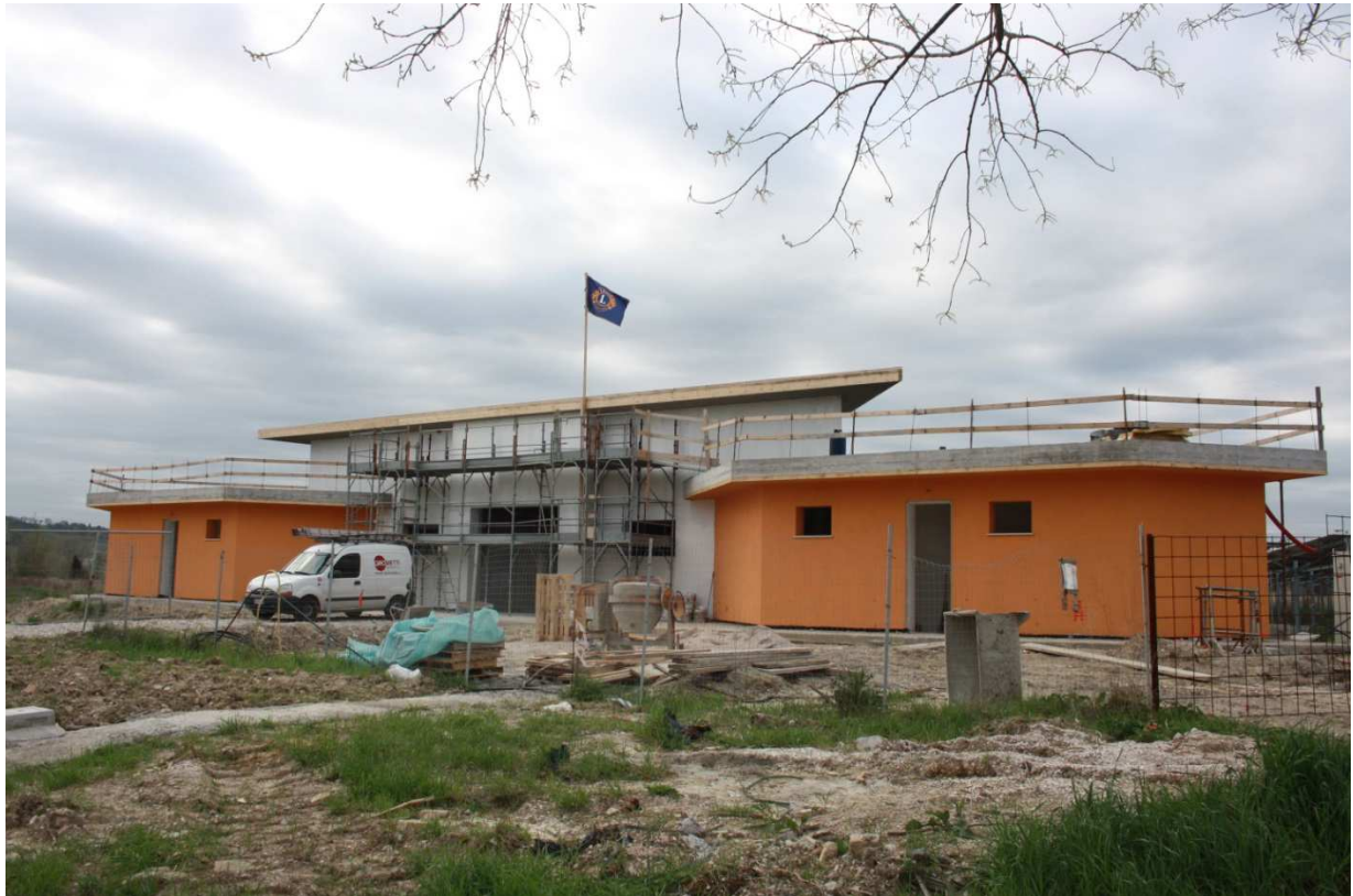
"Casa Tabanelli" in fase di costruzione.
